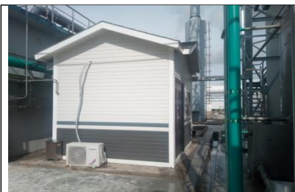
RTO 装置污染源监控室
