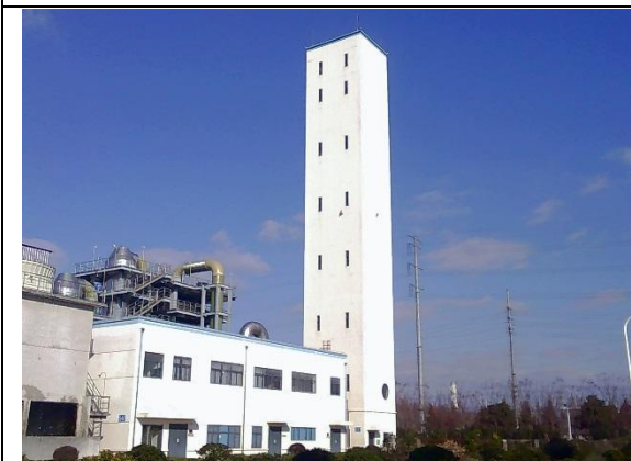
固废焚烧炉排气筒 (FQ-506495)
