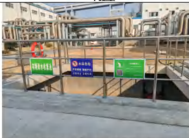
初期雨水池+事故池+污水池+雨水排口
