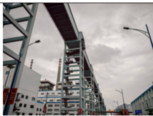
封闭式皮带廊道
